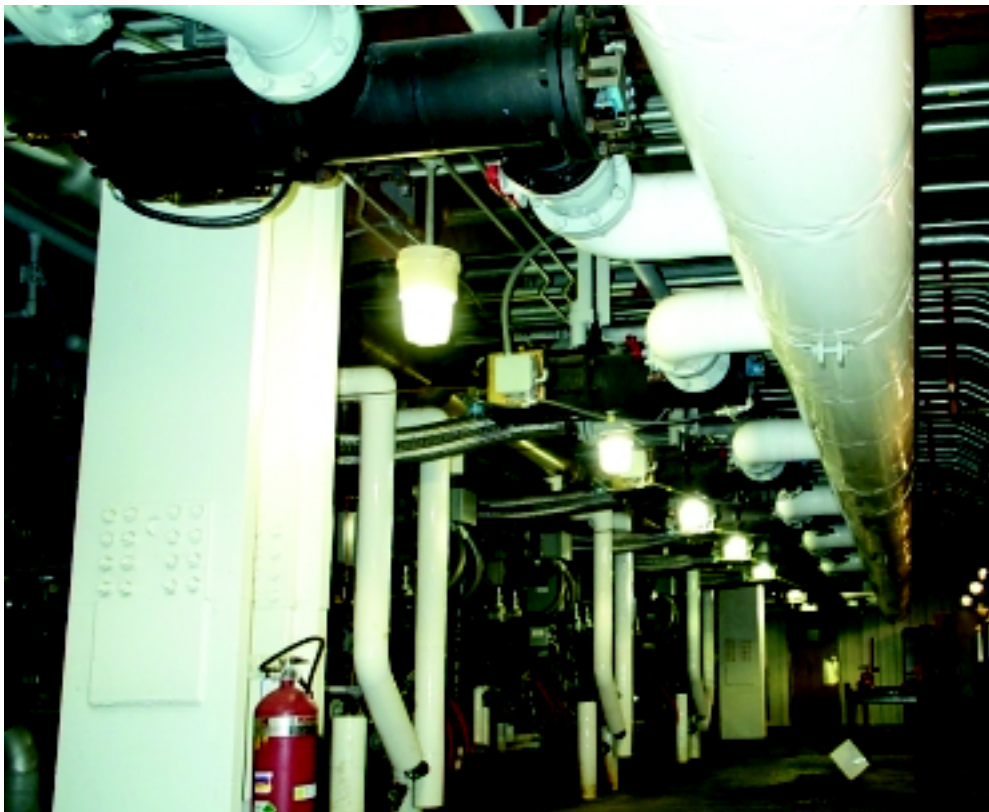
Ejemplo de aplicación de válvulas de gas de 6". La simplificación de la instalación es notable, en especial cuando se trata de cañerías de gran diámetro.
