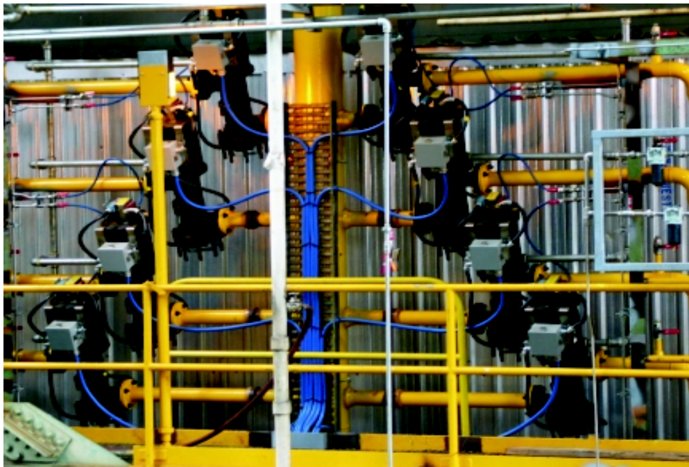
Ejemplo de aplicación de válvulas de gas de 3". Nótese la sencillez de la instalación comprada con el uso de válvulas simples
